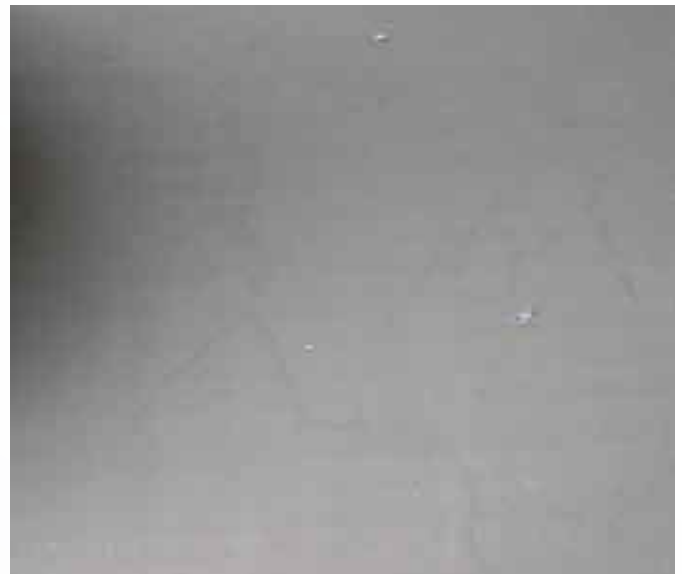
Abb. 6 Fließestrichoberfläche ohne optimierte Sieblinie
