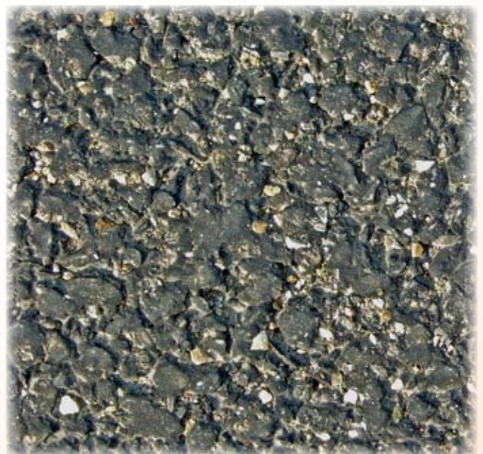
Asphaltdeckschicht mit Alpine Moräne Edelsplitt von OHU
