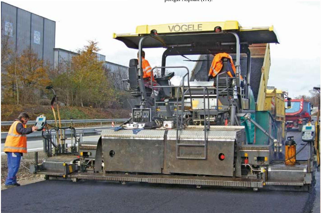
Einbau einer Asphalttragschicht, Fahrbahndeckenerneuerung BAB 5, Weil a. Rhein - Ost, BW
