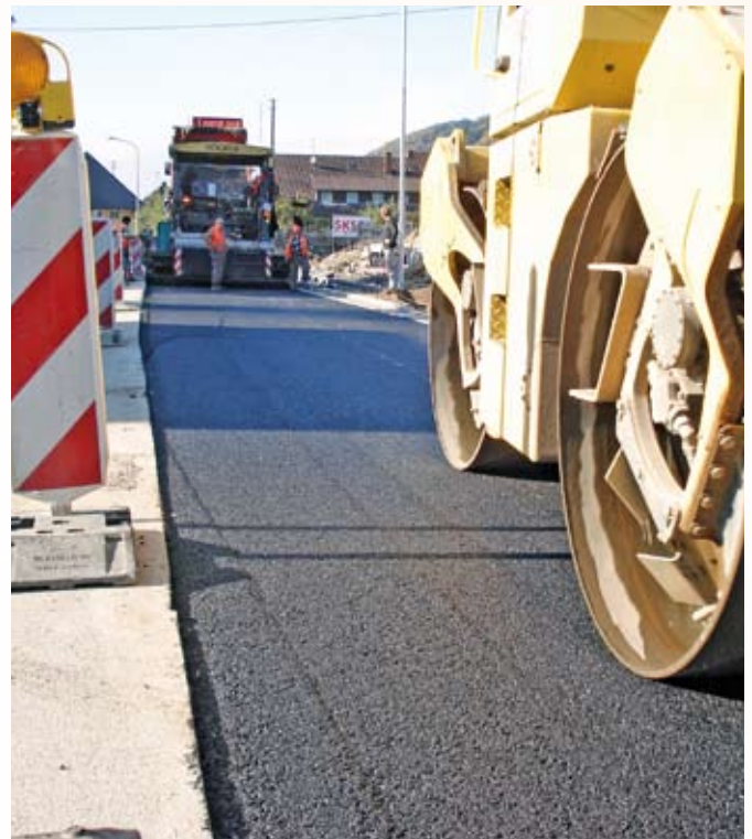
Einbau einer Asphaltbinderschicht
