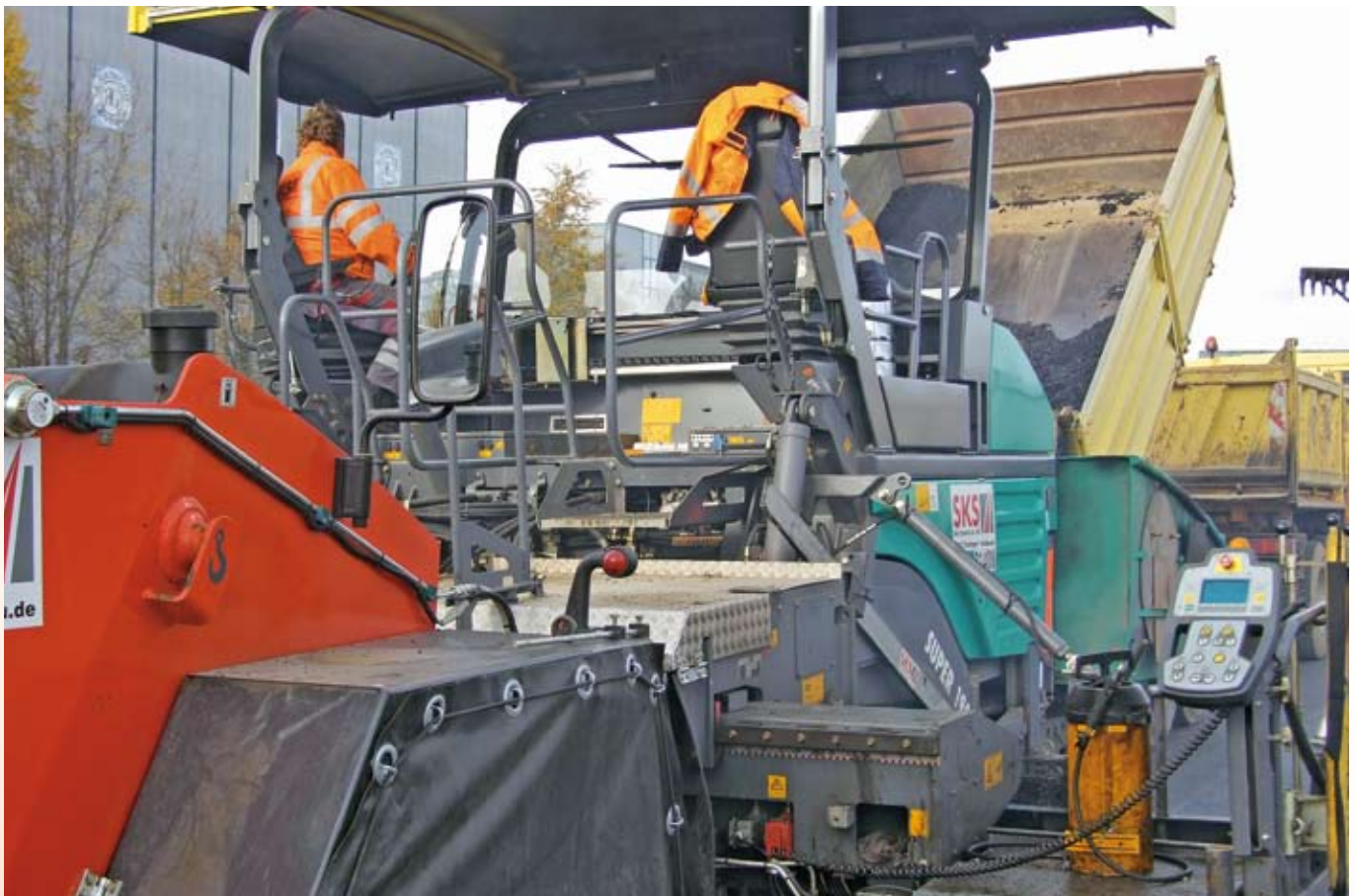
Straßenbaufertiger während der Beschickung
