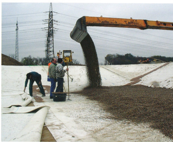
Abdichtung eines Retentions-Bodenfilters
