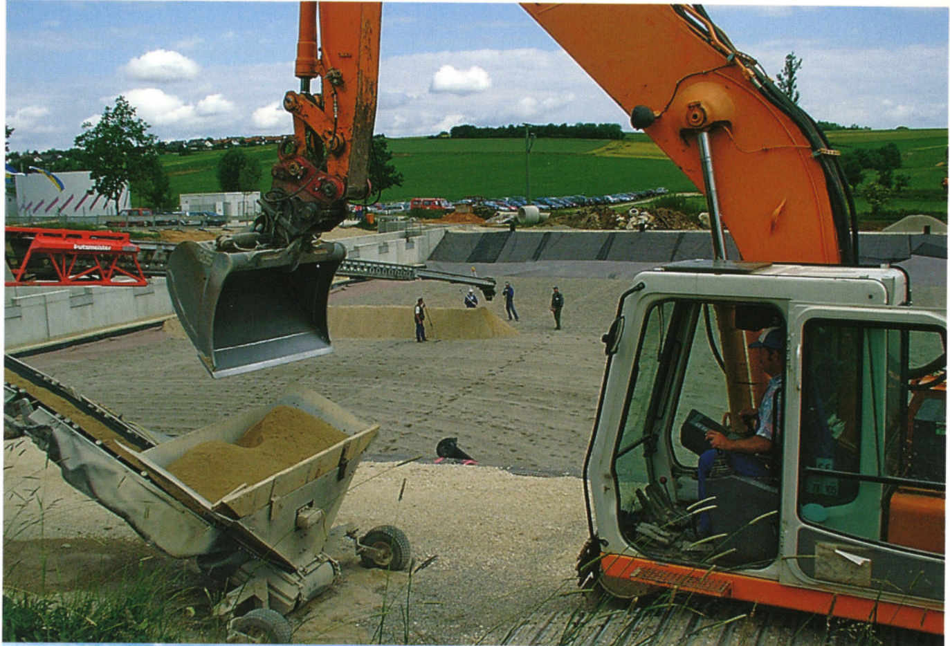
Einbau von Filtersubstrat mit geeigneten Maschinen
