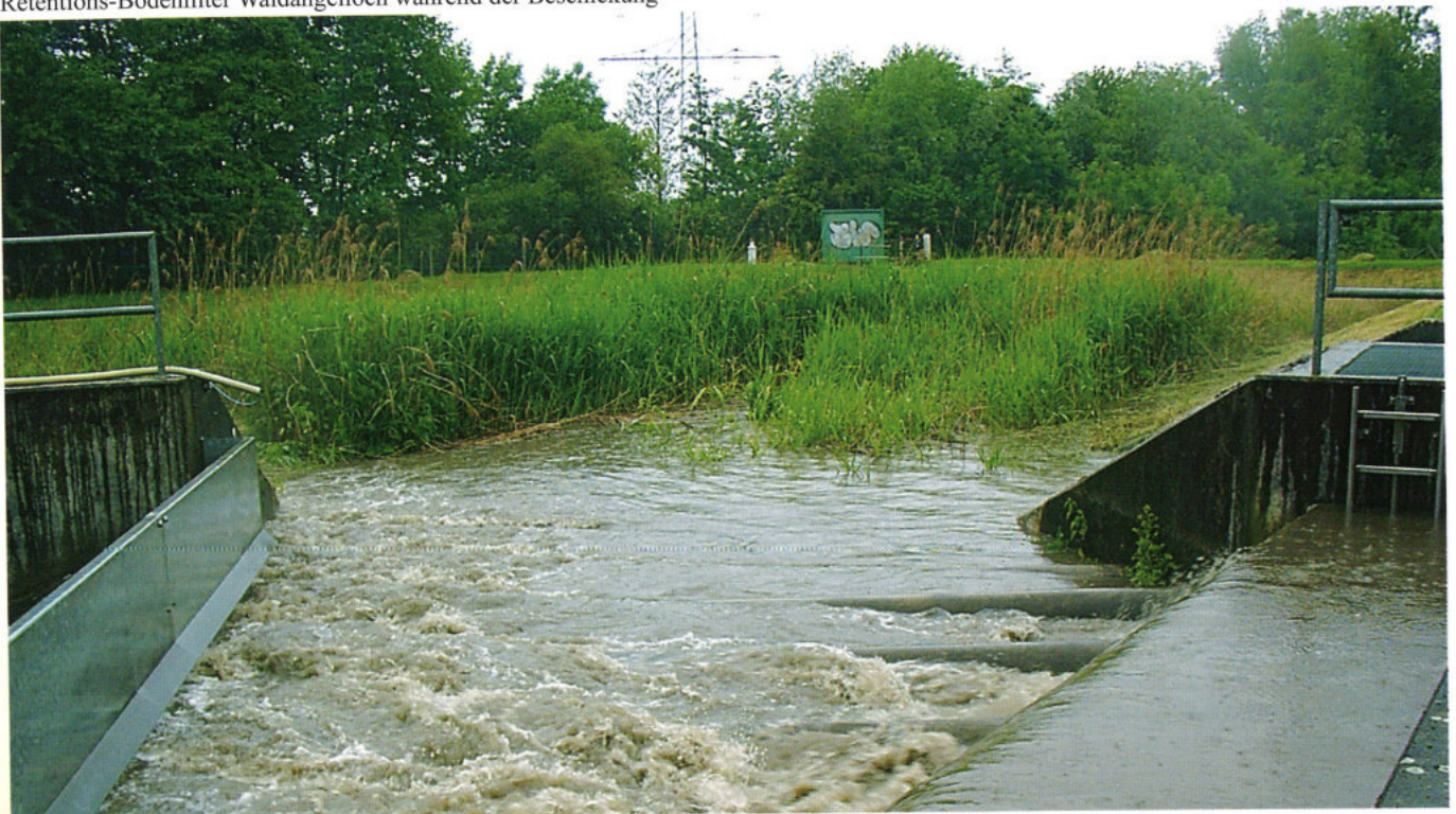
Retentions-Bodenfilter Waldangelloch während der Beschickung
