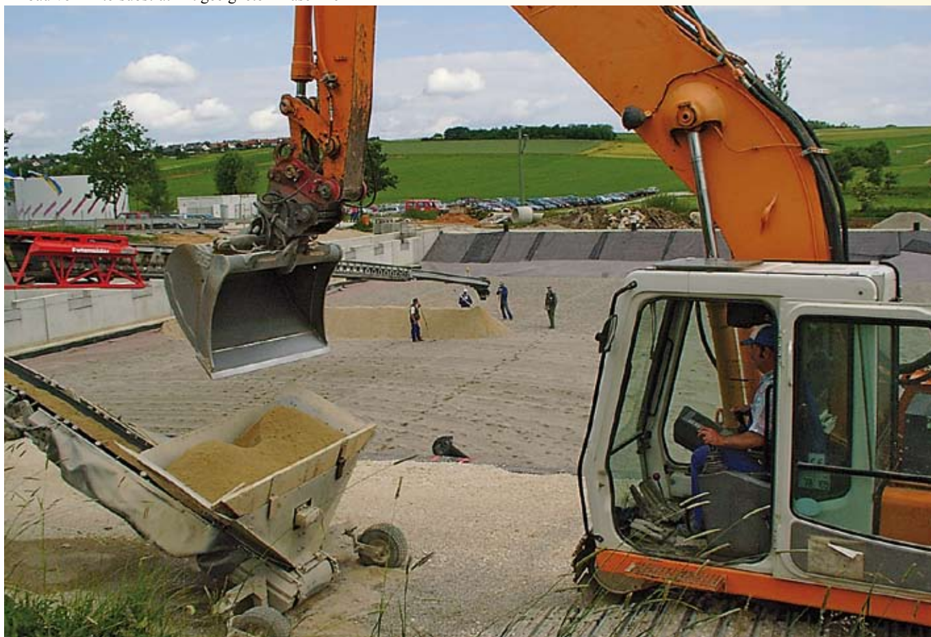
Einbau von Filtersubstrat mit geeigneten Maschinen
