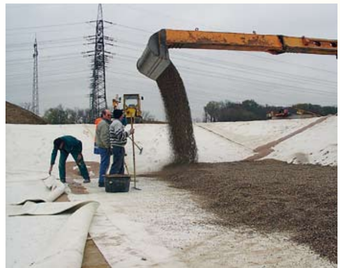
Abdichtung eines Retentions-Bodenfilters
