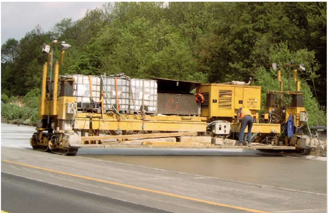
Straßenbaufertiger auf der Autobahn A8
