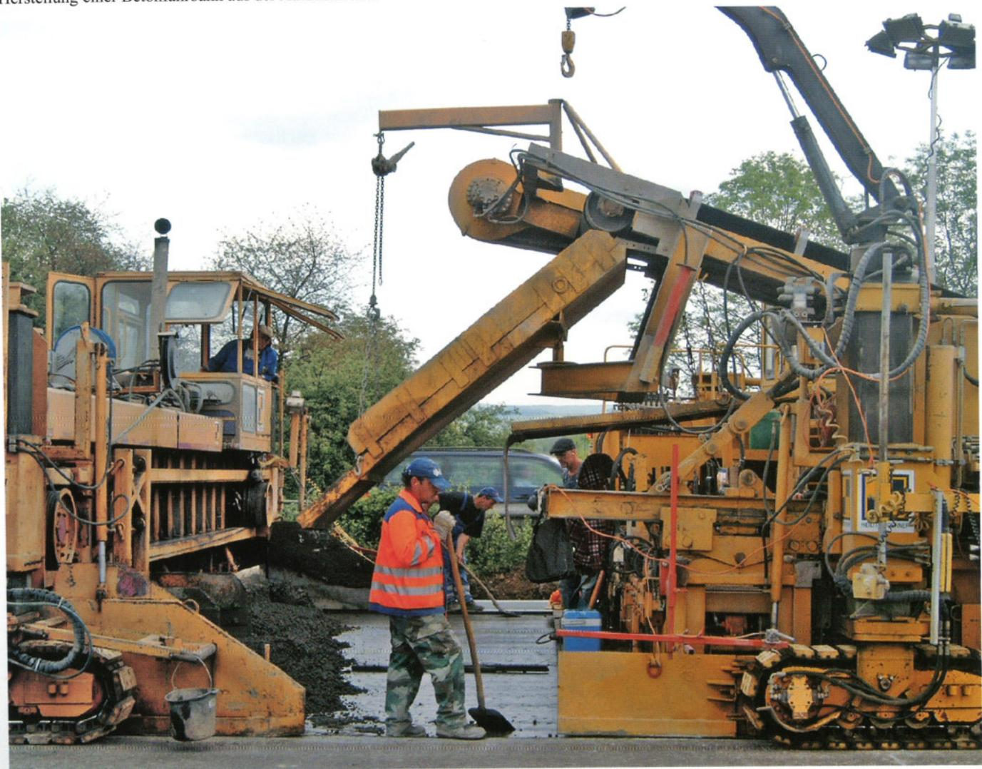
Die Höhenlage (Sollhöhe) und Ebenheit ist durch den Einbauvorgang sicherzustellen. Dies wird zum einen durch die Führung des Straßenfertigerters bewirkt (Schiene oder Laser), zum anderen durch die mitgeführten Glätteinrichtungen, die die Oberfläche herstellen.
